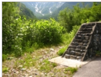
ジグザグる車道をショートカットするように登山道がある。でも入口に案内標識なし。この堰堤の裏側に登山道が続く
